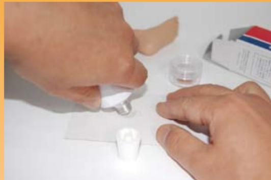
傷口を有機溶剤のアセトンなどでよく洗浄しましょう。その後、プライマーを薄く塗り、夏期は30分、冬期は1時間ほど放置します。(メーカーによって異なりますので間い合わせて下さい。)大量の塗布は逆効果になるので要注意です。乾燥が済んだらシーラントを適量、適当なパレットに出します。
